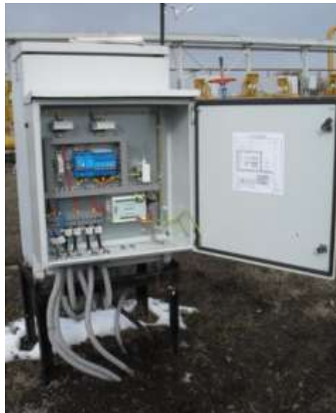
Рис.2 Щиток для установки устройств защиты – ЩЗИП®. Пример реализации.
