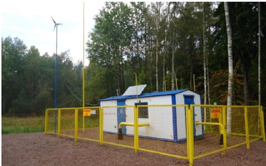
Рисунок 2. КП АГРС – контрольный пункт автономной ГРС, с питанием автоматики от солнечных батарей и ветрогенератора.
