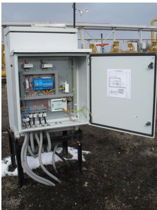
Рисунок 6. ЩЗИП с МККР на объекте эксплуатации ПХГ.
