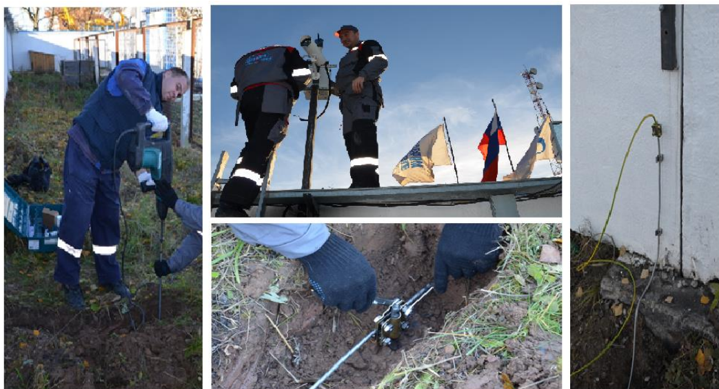
Рис.7 Монтаж молниезащитного комплектного устройства ВК
