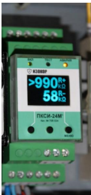
Рисунок 9 – Изменение показаний ПКСИ-24М при уменьшении сопротивления в два раза
