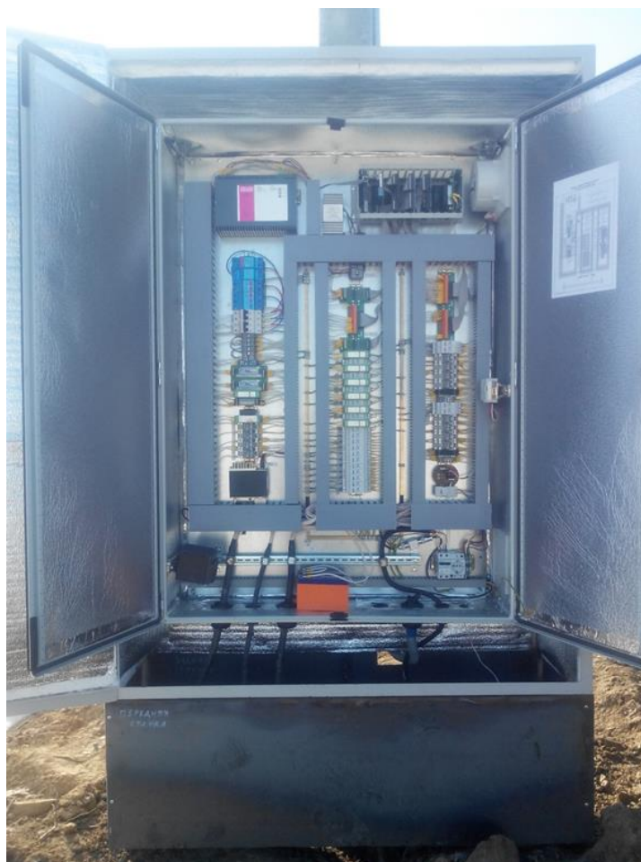
Рисунок 4 – Внешний вид ЩЗИП на объекте эксплуатации
