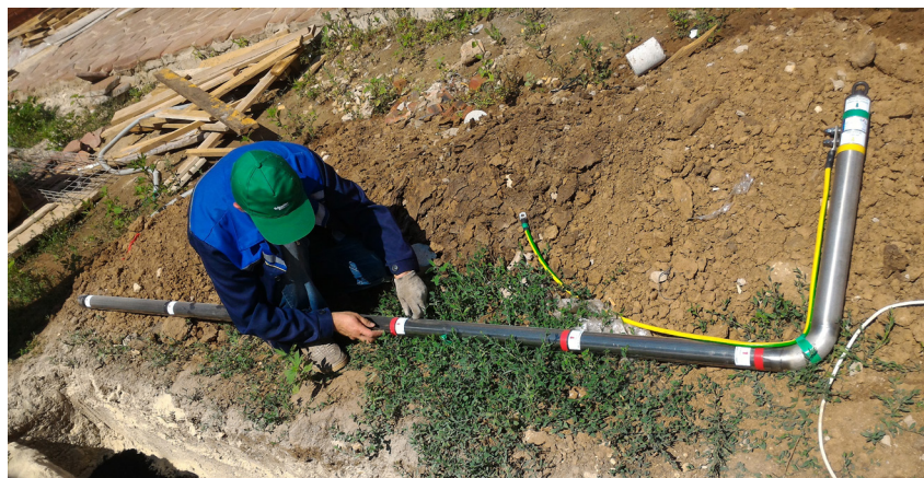
Рис. 2. Электролитический заземлитель горизонтального исполнения
